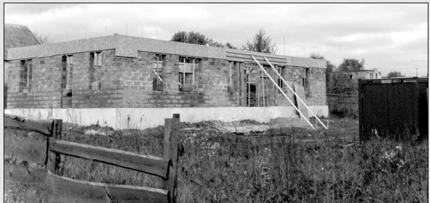
Atliekami Nemėžio kaimo totorių bendruomenės namo statybos darbai.
